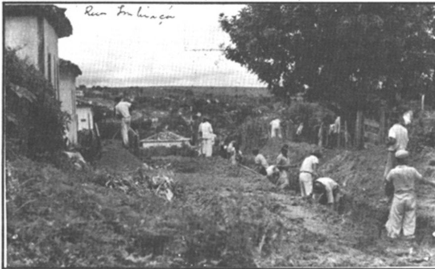
Serviço de canalização de água na Rua Imbiacã. Administração Álvaro Cardoso (1940-1941). (Arquivo SPH/FCCB). Autor: Parateca
